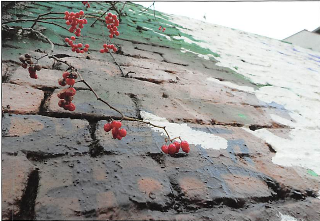
Cerises sauvages poussant à travers les fissures des vestiges du mur de Berlin.
