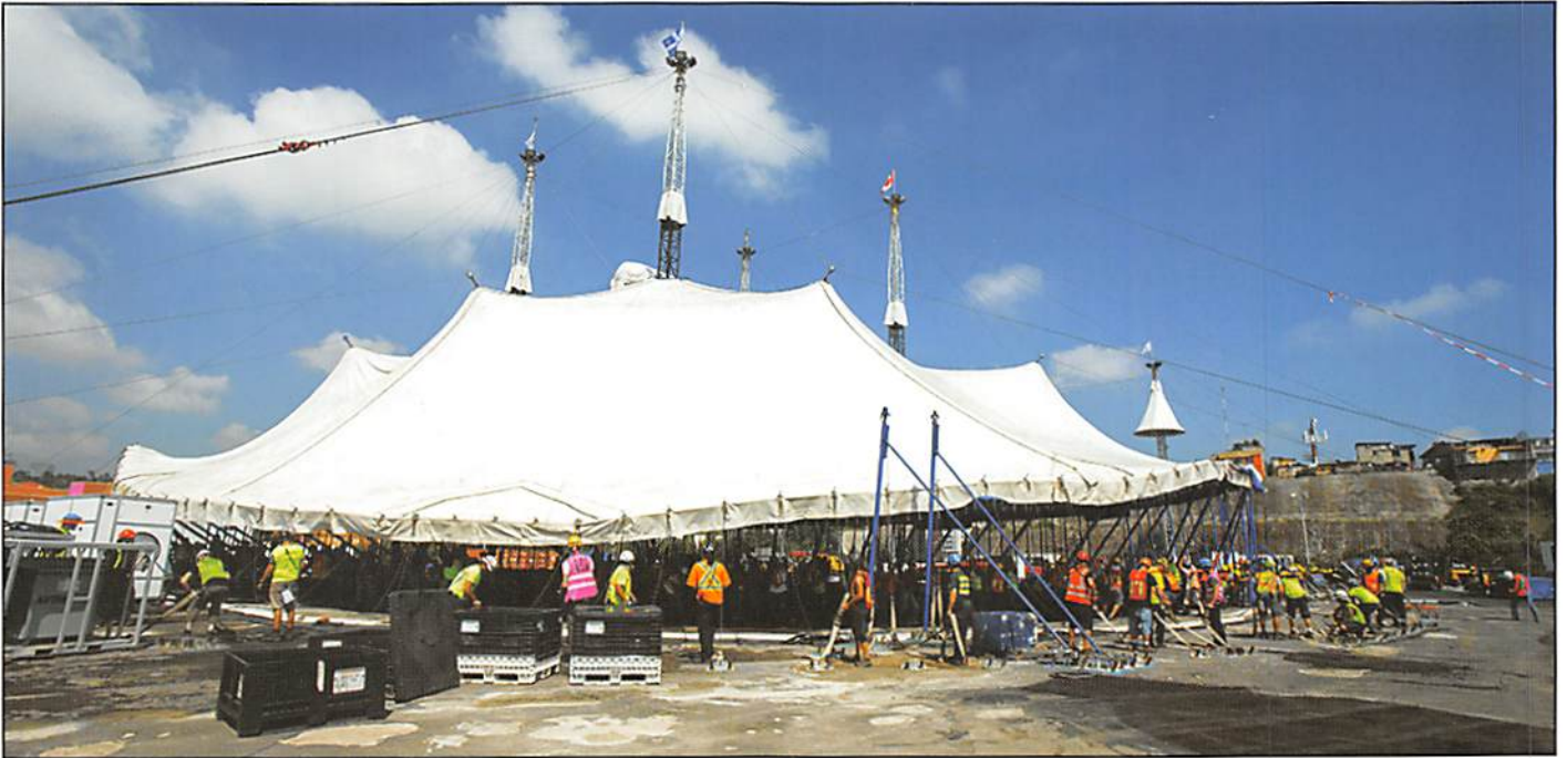
Montage du chapiteau à Quito, en Équateur.
