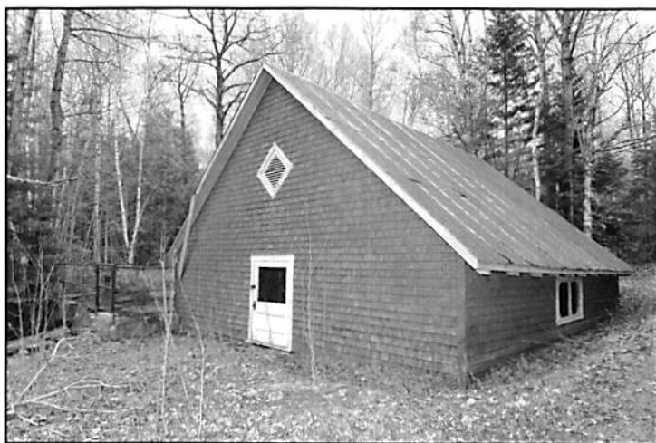
Bâtiment du réservoir d'eau
