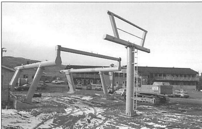
Construction de la remontée mécanique quadruple en 1987.
