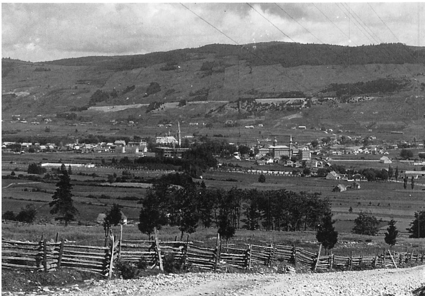
Vers Baie-Saint-Paul au milieu du 20 e siècle
