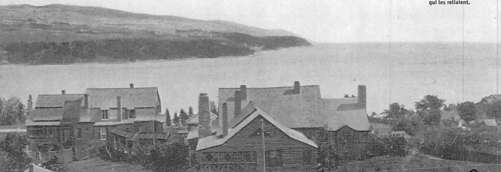
Les maisons avec la passerelle qui les reliaient.
