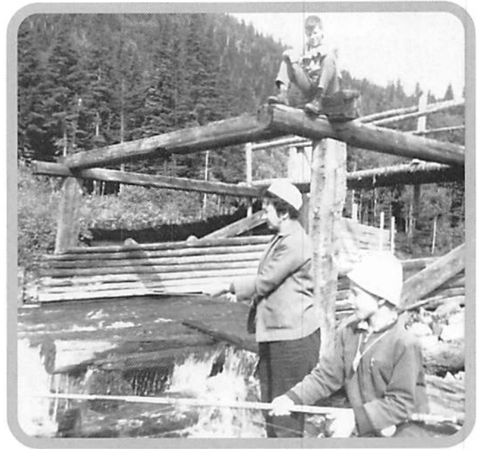
Barrage du Deuxième lac des Marais en juillet 1963. Il fut détruit par la crue des eaux à la fin des années 1960.
