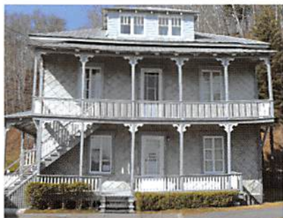
Une maison construite vers 1911.
