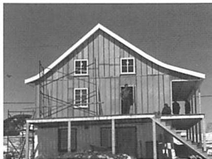
Côté sud extérieur en rénovation. 1978
