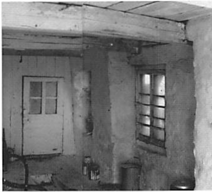
Premier plancher, intérieur avant rénovation.
