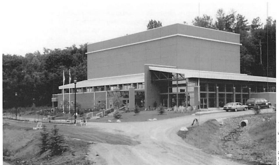
Construction de la salle François-Bernier en 1996.
