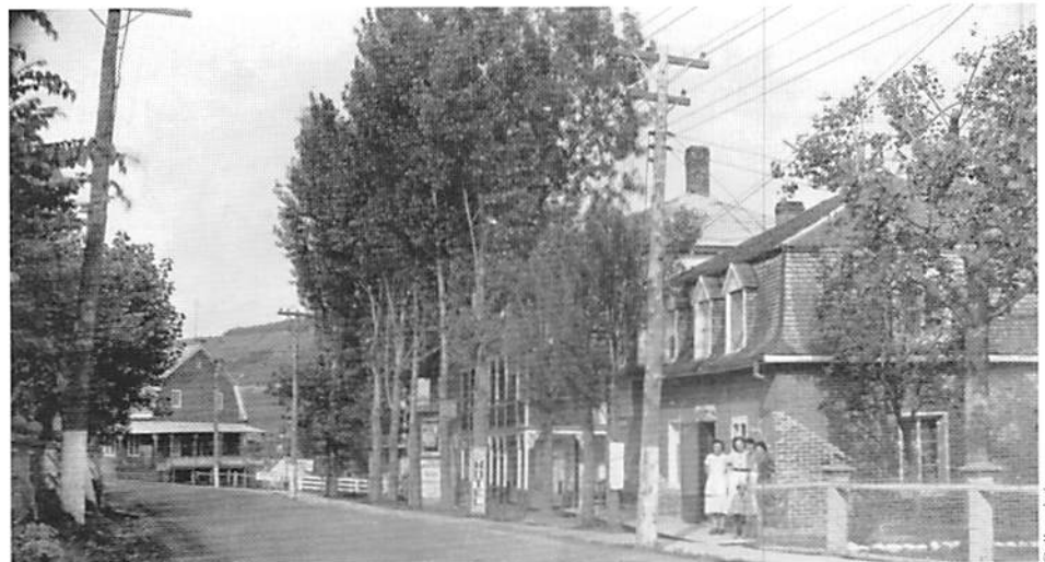
Maison des artistes-peintres Blanche et Yvonne Bolduc vers 1940. Les soeurs Bolduc offraient leurs oeuvres le long de la route sillonnée par les touristes en été. Sur ce même site, rue Ambroise-Fafard, s'élève aujourd'hui le Centre d'exposition de Baie-Saint-Paul.
