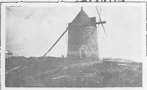
Le moulin du séminaire de Québec
