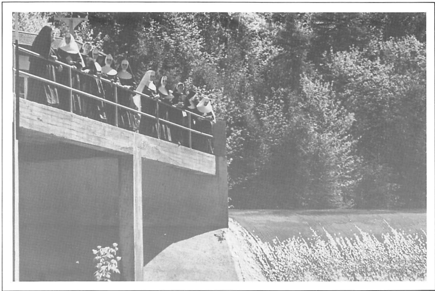
Au barrage de l'usine électrique
