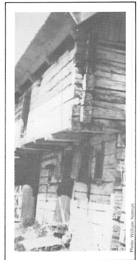
Encorbellement de la Grange Bhérier
