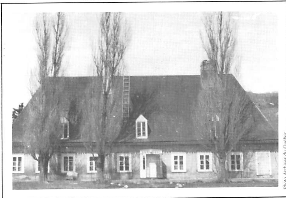
Ancienne propriété du Séminaire de Québec à Baie-Saint-Paul. Construite entre 1715 et 1718, elle fut incendiée en 1926 et n'a pas été reconstruite. Kalm résida vraisemblablement dans cette maison lors de son séjour à Baie-Saint-Paul.
